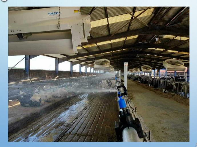
8 X CYCLONE VHV72" + SOAKING SYSTEM ON TOP OF FEEDGATE FULLY AUTOMATIC CONTROL FOR FAN SPEED AND SOAKING TIMES
